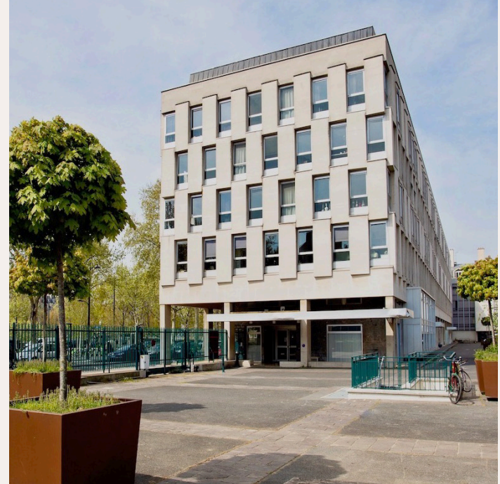
Vue du bâtiment principal sur le site du Marais de la Cité internationale des arts © Maurine Tric
